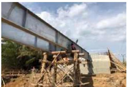
Gambar 18 Pemasangan Baja Struktur
