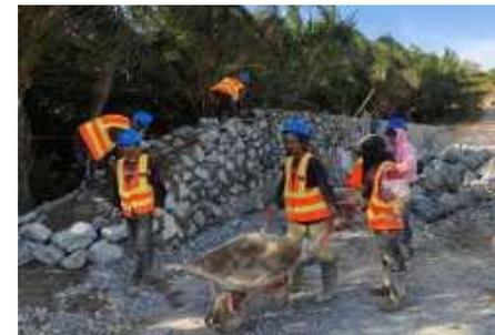
Gambar 17 Pekerjaan Pemasangan Batu
