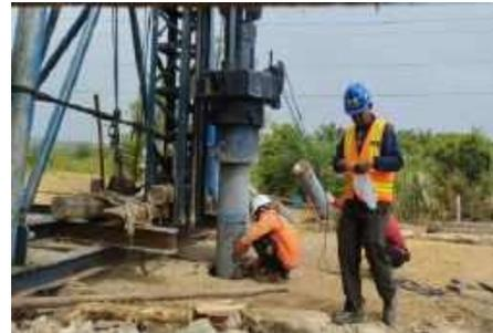
Gambar 13 Pekerjaan Pemancangan Pondasi
