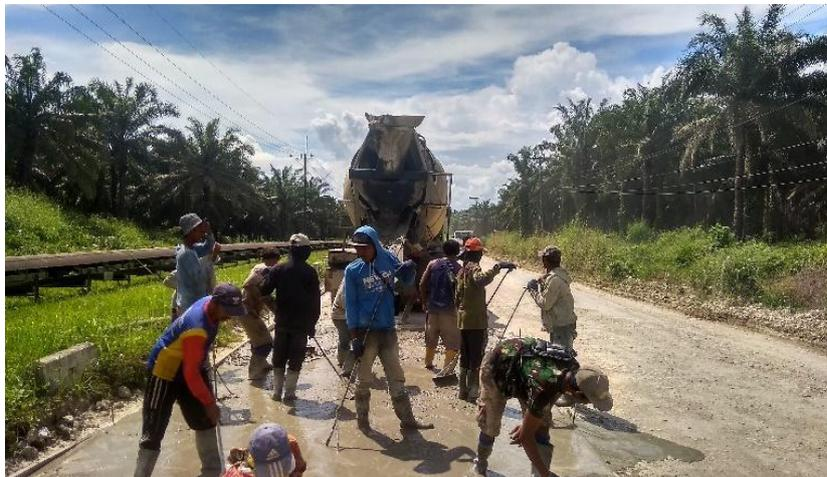
Gambar 5. Pengecoran Lantai Kerja
