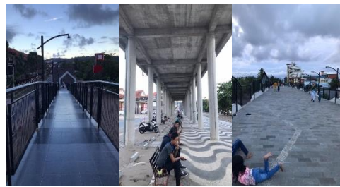
Gambar 10. Setelah pembangunan JPO
